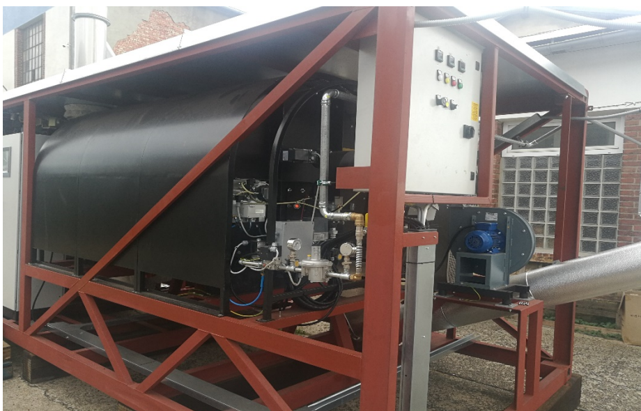
Obr. 13 pohled z boku na dospalovací pec včetně ovládání a dmychadla. Částečně je vidět i chlazený dopravník pro odvod biocharu z retorty
