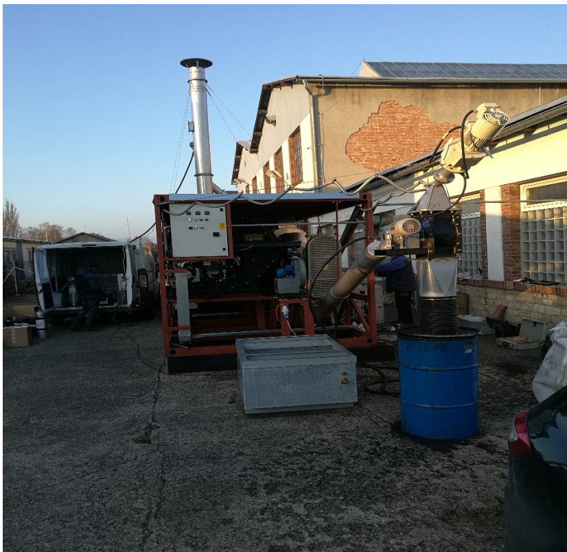
Obr. 20 pohled na zařízení od výstupní části. Vlevo je vidět zádň část dodávkového vozu ve kterém byla aparatura pro měření emisí. Je vidět i kabel spojující komínek na zařízení s měřicí aparaturou.
