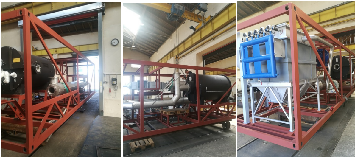
Obr. 6, 7, 8. Postupná montáž jednotlivých dílů do kontejneru. V pozadí na obrázcích portálový jeřáb
