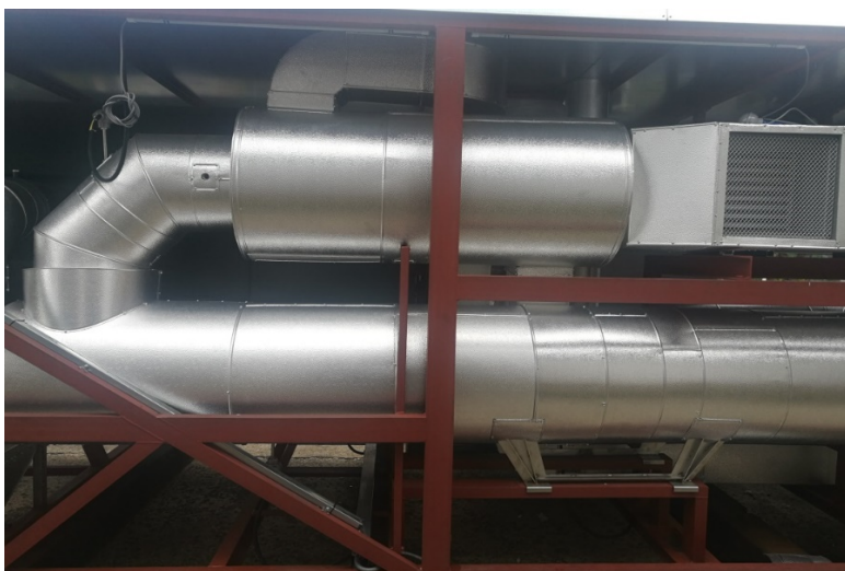
Obr. 10. pohled na retortu dole s odvodem spalin z dvouplášťové retorty do výměníku spaliny vzduch
